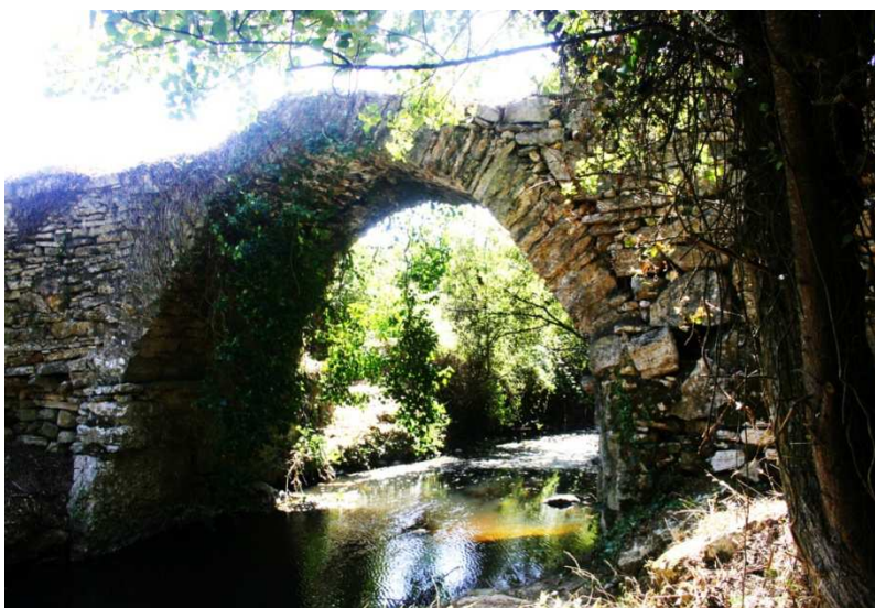
Figura 6 - Ponte Romana da Catribana.
