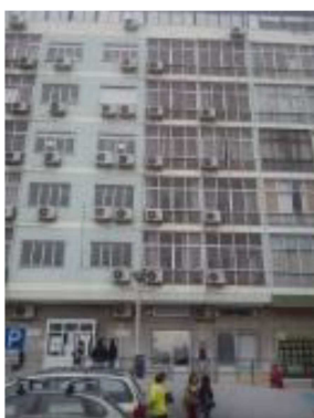
Figura 2. Instalações das UCSP Algueirão
